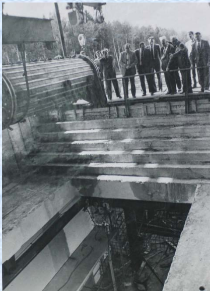
Загрузка в тоннель ускорителя
