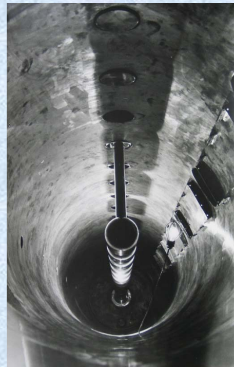
Монтаж трубок дрейфа
