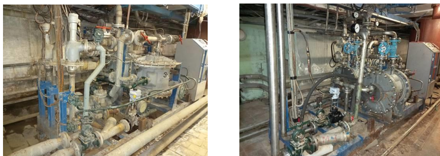
Рисунок 9 – Терморегулирующая установка до (слева) и после (справа) модернизации
