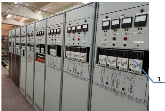
Рисунок 10 – Новые источники питания 1 в стойках старых источников
