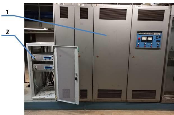
Рисунок 11 – Старые (1) и современные (2) источники питания
