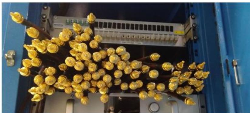
Рисунок 31 – Сигнальные кабели стороны С до монтажа на панель
