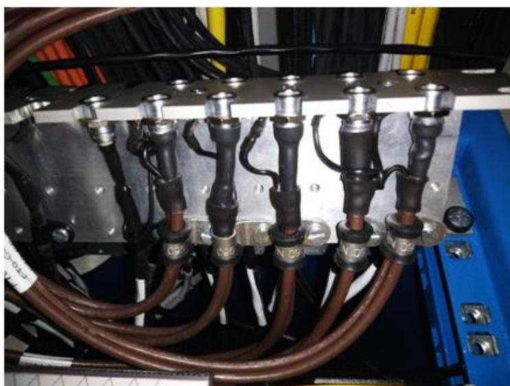
Рисунок 34 – Триггерные кабели, смонтированные на панель центральной триггерной системы (CTS)
