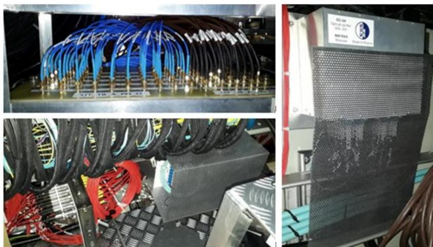
Рисунок 9 – Внешний вид переходных панелей для подключения сигнальных и высоковольтных кабелей детектора FIT-A
